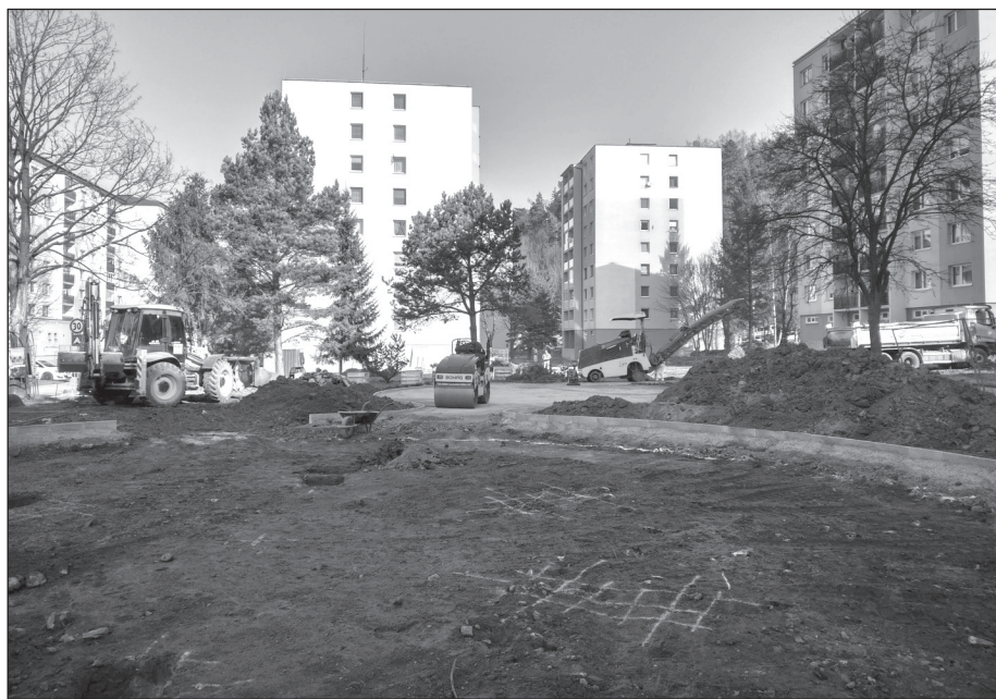
Práce na revitalizácii vnútrobloku medzi ulicami Pod lesom a Severná.
