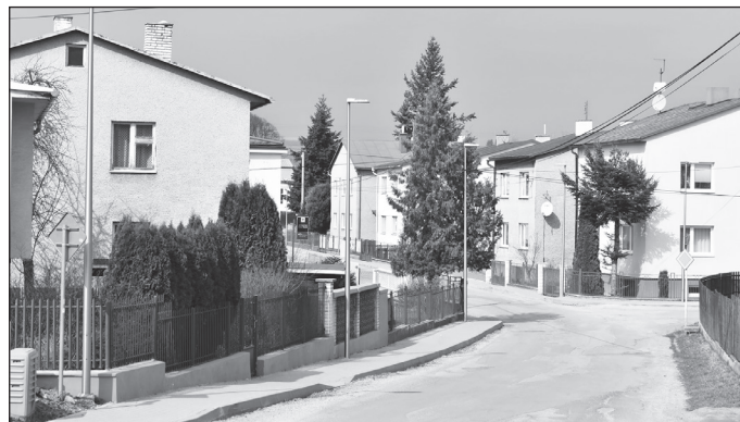
Chýbajúce opravené chodníky na Sihoti.
