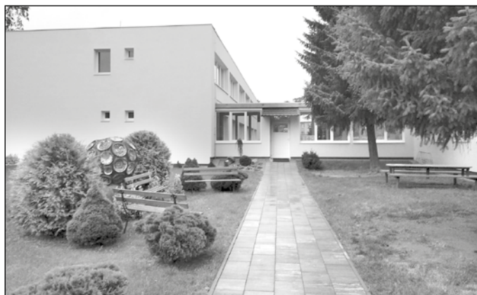
Pohľad na prednú časť budovy po rekonštrukcii.
