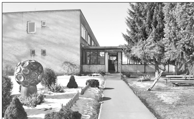
Pohľad na prednú časť budovy pred rekonštrukciou.
