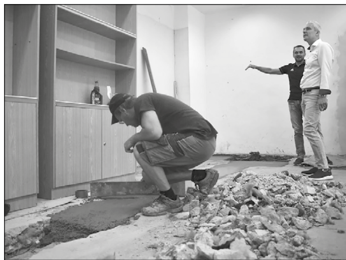
Opravy potrubia v jednej z učební Základnej školy s materskou školou Nižná brána.
