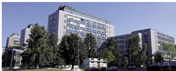
Obrázek 26 budovy fakulty strojní a elektro ČVUT v Praze, kde byl úspěšně použité prediktivní vytápění (zdroj: energocentrum)
