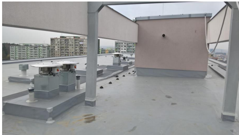
Obrázek 30 Revitalizovaný dům na Praze 4 s nefungujícím systémem větrání (zdroj: vlastní)
