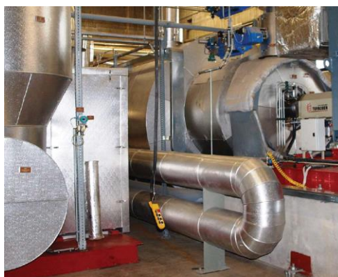
Obrázek 21 ORC modul v biomasové kotelně v Žatci (zdroj: TENZA a.s.)
