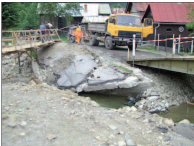
Práce v obci Sulín v okrese Stará Ľubovňa, kde je kritická situácia, pretože tam urýchlene treba opraviť most, aby sa obec napojila na riadnu dopravnú sieť.
