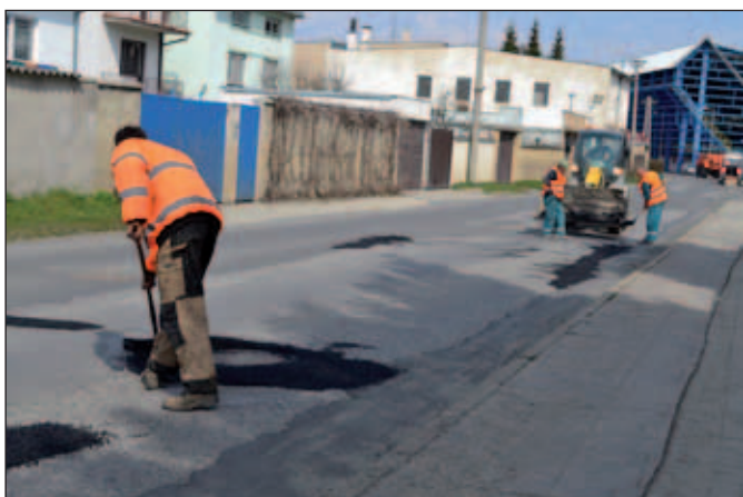
Na Trhovišti už opravujú najväčšie výtlky.
