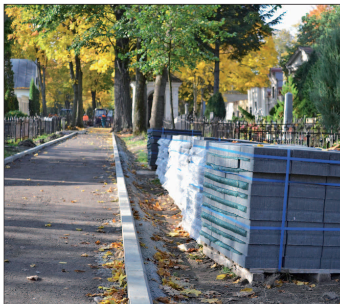
Chodník na cintoríne bude pokrývať kamenná dlažba.
