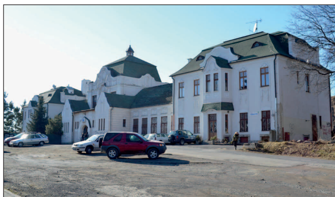
Budova železničnej stanice v Kežmarku je v zlom stave, o niekoľko rokov sa možno dočká investícií.
