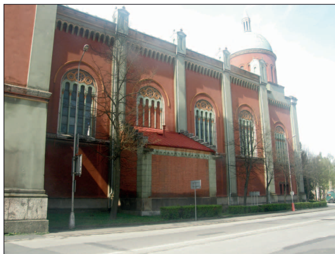
Súčasťou nového evanjelického kostola v Kežmarku je i mauzóleum Imricha Thökölyho, ktoré je v jeho pravej časti.
