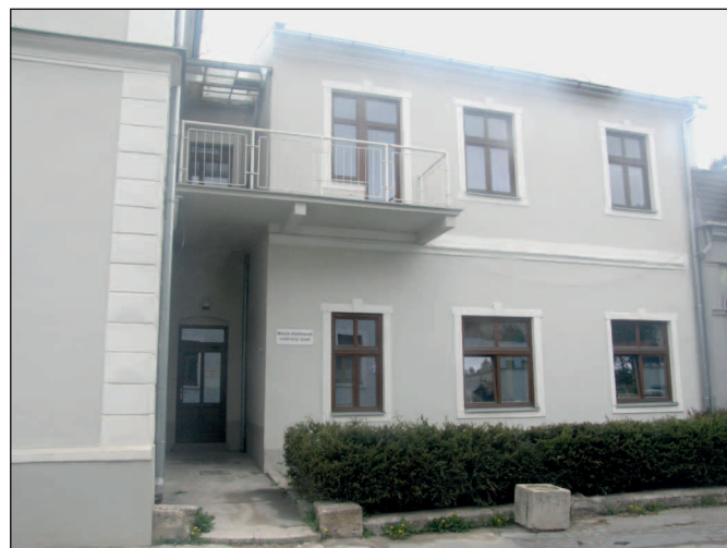
Časť zrekonštruovanej budovy, kde má sídlo matričný úrad.
