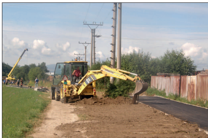
Výstavba cyklistického chodníka v meste Kežmarok, po rieke Poprad, je v plnom prúde.
