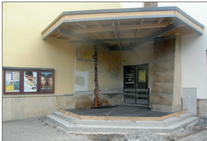
Rekonštrukcia nového vchodu do kežmarského kina začala v polovici júla.
