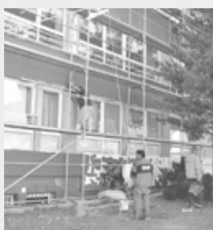
Vďaka dotácii z Environmentálneho fondu bude zateplená budova Základnej školy Dr. D. Fischera i telocvičňa.
