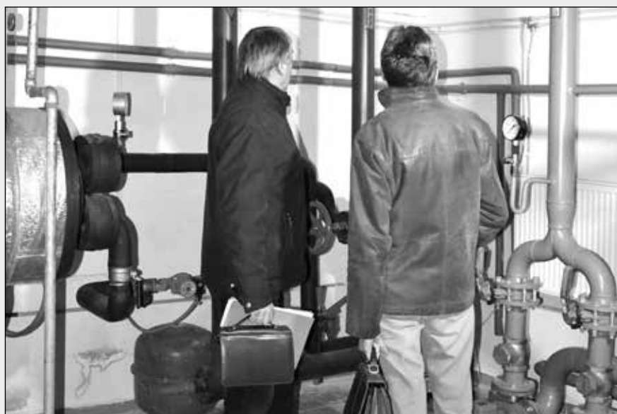
Projektanti skontrolovali koncom novembra skutkový stav zimného štadióna. Okrem iného sa zaujímali aj chladiace zariadenie.
