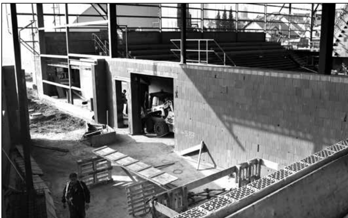
Predseda PSK si počas návštevy Kežmarku pozrel priestory budúceho kampusu a progres na stavbe zimného štadióna.
