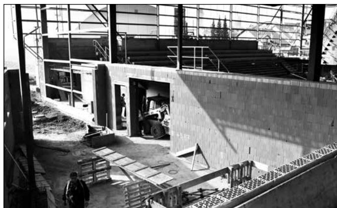
Množstvo stavebného materiálu a ľudí – tak dnes vyzerá zimný štadión.
