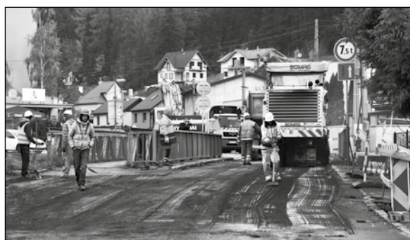
Most na Severe sa dočká výmeny. Práce pokračujú, a preto po ňom nemôžu prechádzať ani autá ani chodci. Plánovaná odstávka potrvá do 4. marca 2018. Obchádzková trasa vedie po ulici Nižná brána cez most pri objekte STS Kežmarok.
