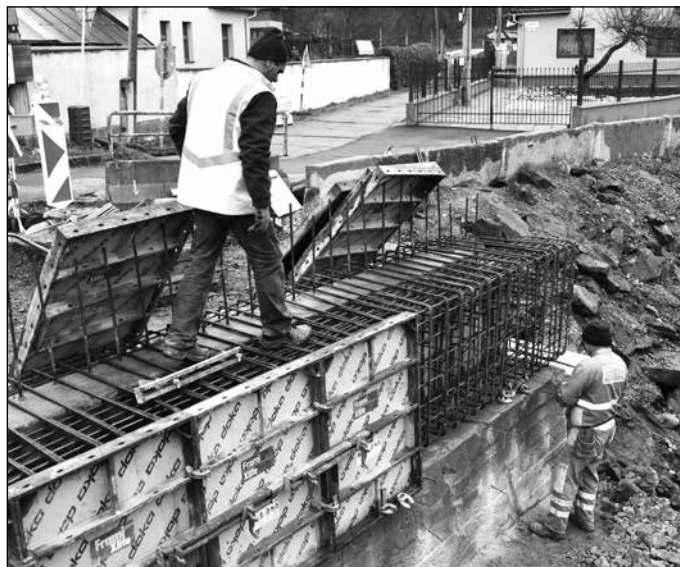
Výmena mosta na Severe.
