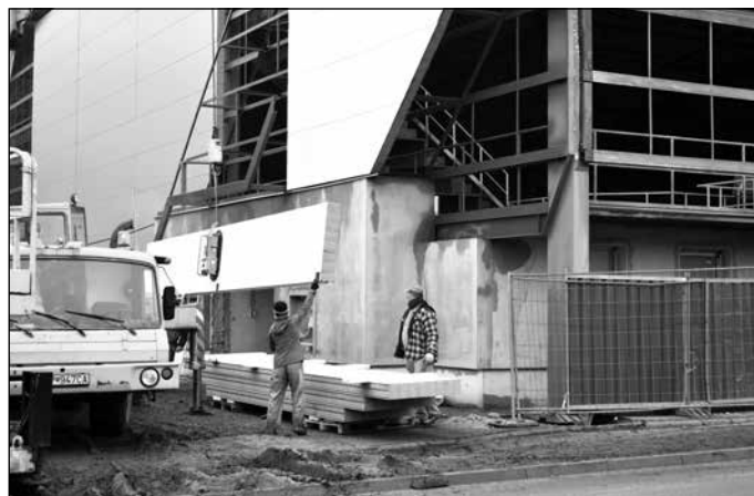
Rekonštrukcia zimného štadióna je v plnom prúde.
