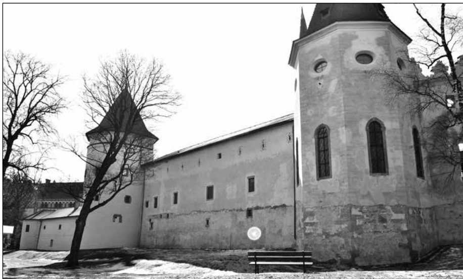
Rekonštrukcia múrov hradu viditeľne pokračuje.
