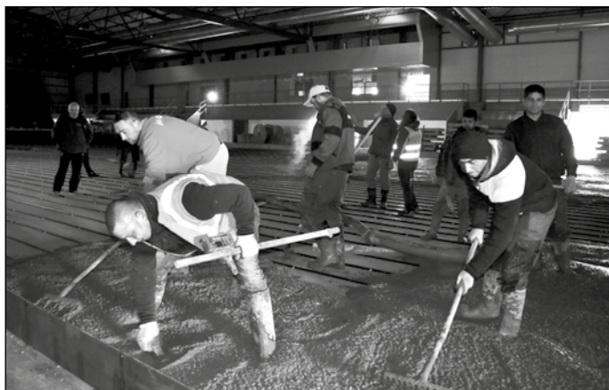
Začali sa práce na ľadovej ploche.
