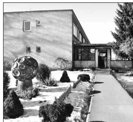
Na Materskú školu Možiarska čaká rekonštrukcia.
