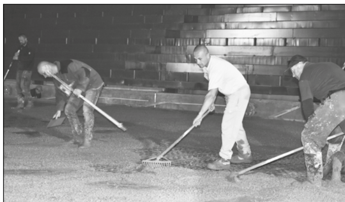
Koncom apríla sa ľadová plocha betonovala.
