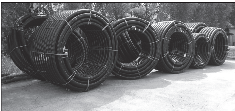
Potrubia ústredného kúrenia a teplej úžitkovej vody sú už pripravené.
