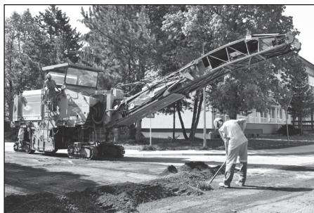
Frézovanie vrchného asfaltového koberca.
