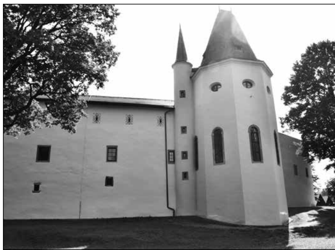
Po celom obvode zrekonštruovaného hradného múru je osadený drenážny odvodňovací systém.
