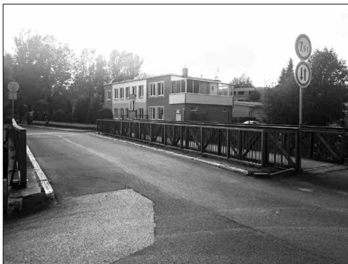
Takto vyzeral most pred rekonštrukciou.
