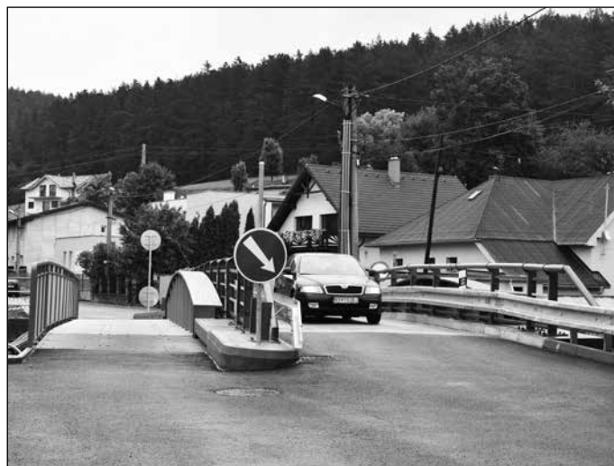
Most po ukončenej rekonštrukcii.
