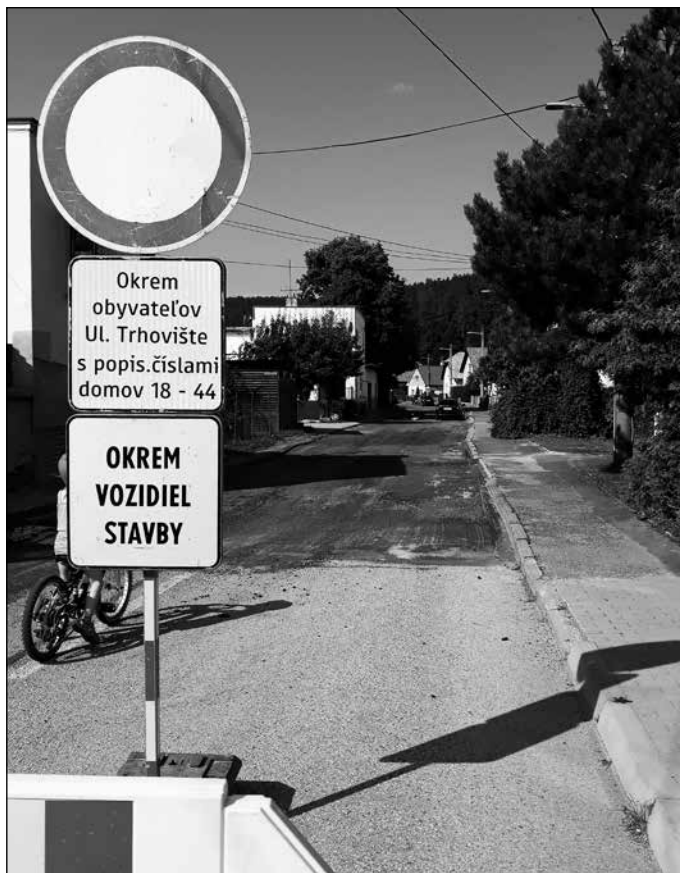
Ulica Trhovište počas rekonštrukcie.
