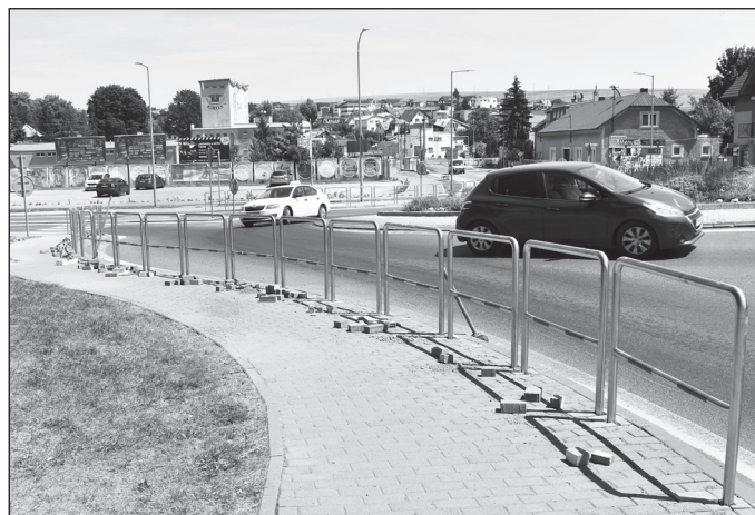
Nové zábradlie pri okružnej križovatke.
