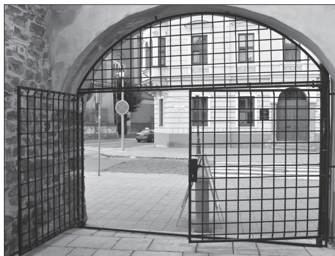
Pri prevádzke Potraviny Non Stop 24 pribudla veľká železná brána, ktorá sa zamyká vo večerných hodinách. Jej osadenie má zabrániť hlučným nočným nájazdom v blízkosti obytných domov a rušeniu nočného kludu.
