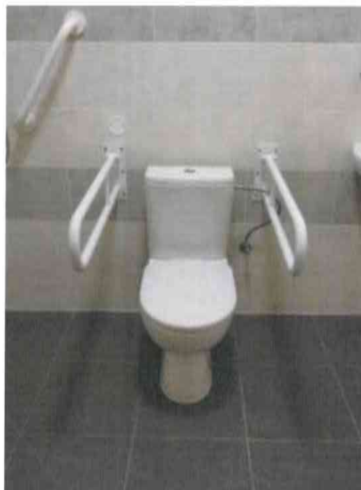
Nové bezbariérové WC
