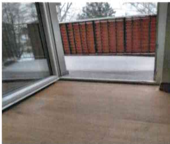
Nový bezbariérový vstup na balkón
