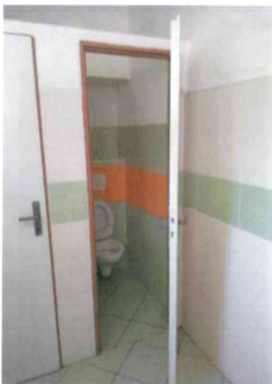
Pôvodne – spoločné WC vrámci chodby
