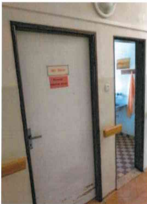
Spoločné WC v rámci chodby
