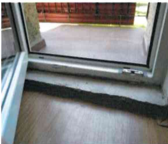
Pôvodný vstup na balkón
