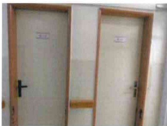
Pôvodne – spoločné WC vrámci chodby
