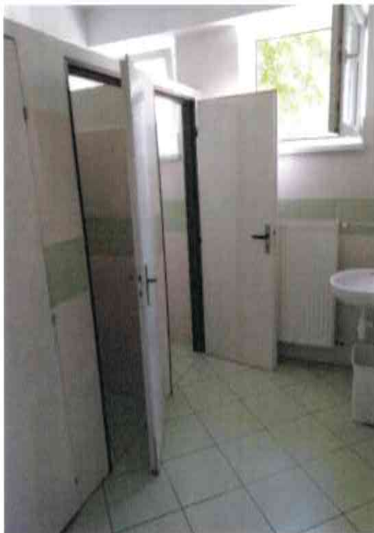
Spoločné WC v rámci chodby
