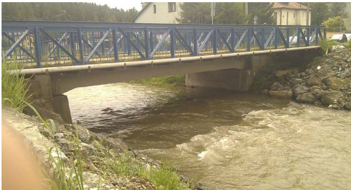
Obr. 31: Fotografia jestvujúceho mostného objektu medzi ulicami Pod lesom a Hradskou cestou
