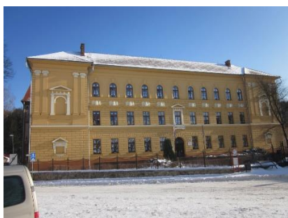
ZŠ Grundschule – hlavná budova
