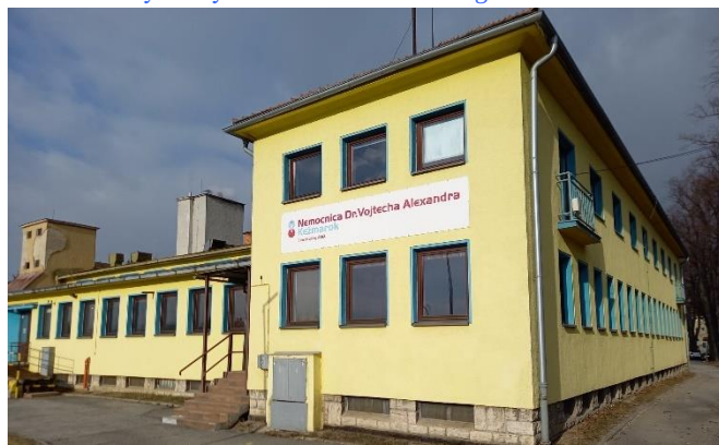
10. Administratívna budova NEMOCNICA VOJTECHA ALEXANDRA
