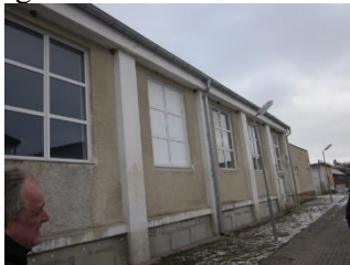
2. Mestská športová hala
