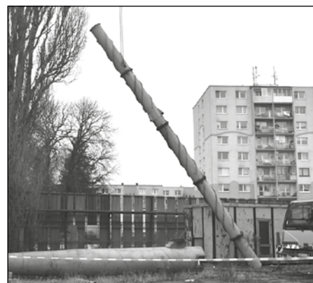
Odstraňovanie komína v priestoroch bývalých kasární.
