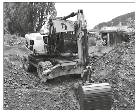
Na odstránení envirozátáže pracuje ťažká technika.
