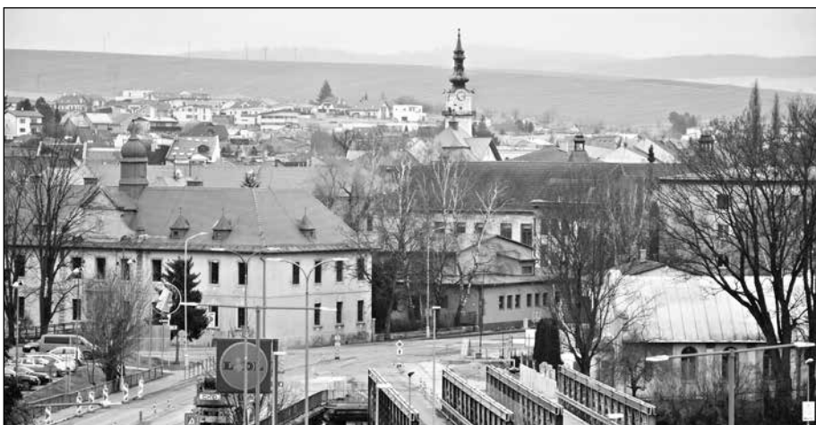
Pred samotnou výstavbou došlo k vybudovaniu druhého dočasného mosta.
