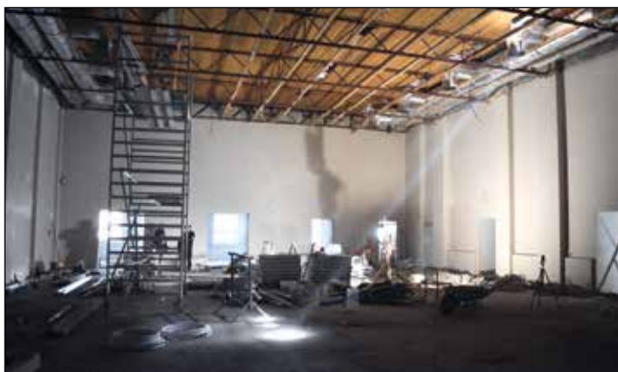
Rekonštrukcia telocvične v Športovej Hale Vlada Jančeka..
