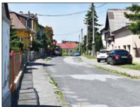
Miestna cesta na Ulici Biela voda.
