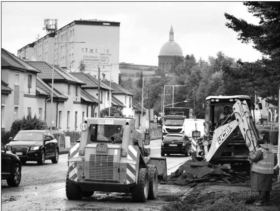
Práce na úprave ciest začali na Huncovskej ulici a budú pokračovať až po Billu. Druhá etapa začne od Nákupného strediska Lidl a skončí pri spoločnosti Aspel.
