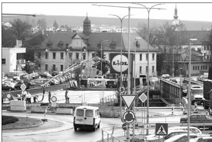
Rekonštrukcia kežmarského mostu by mala trvať deväť mesiacov.
