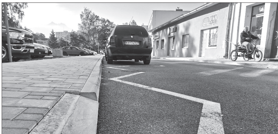
Zrekonštruovaný úsek Baštovej ulice.
