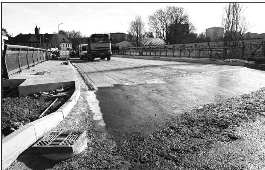
Posledné práce na moste pred kladením nového asfaltu.
