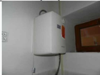
Soc. zariadenie nebyt. priestoru č. 3
