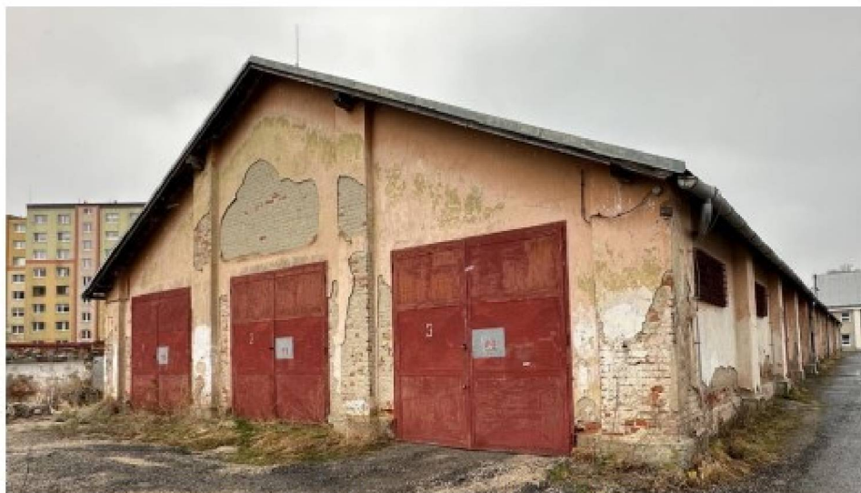
Obrázok 6 – Pohľad severnú a východnú stenu objektu
