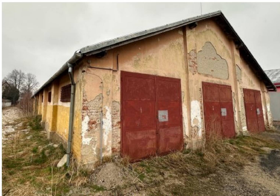
Obrázok 7 - Pohľad južnú a východnú stenu objektu
