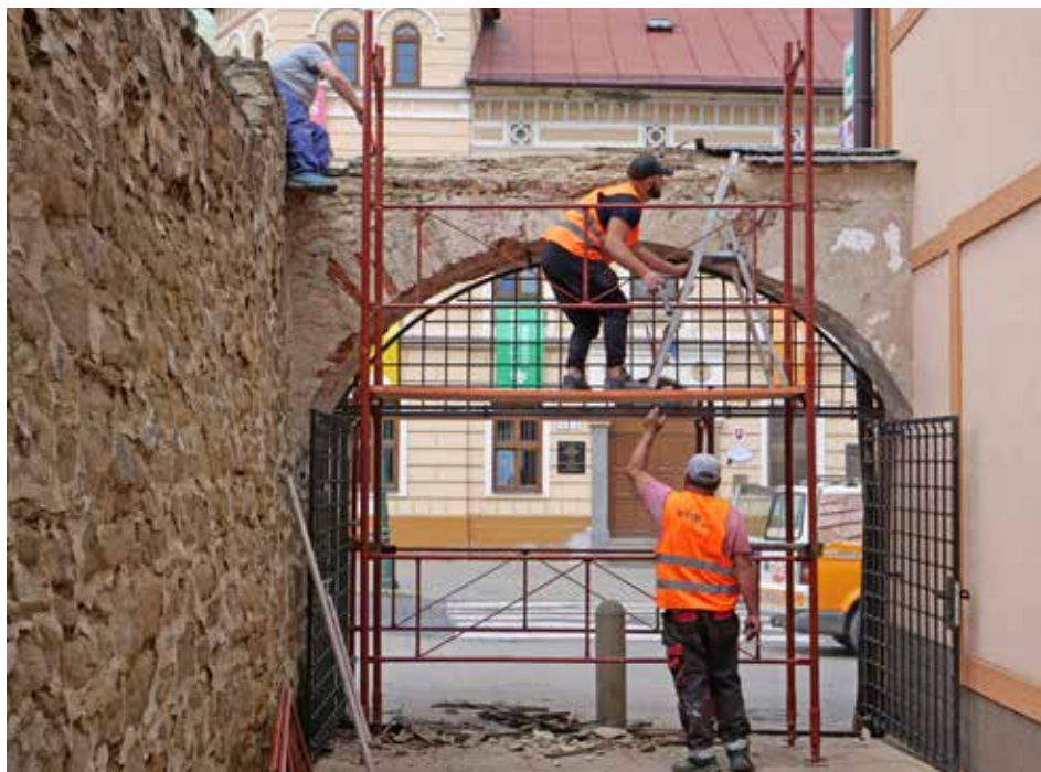
Rekonštrukcia rozperného oblúka z Hviezdoslavovej ulice na Ulicu Priekopa.
