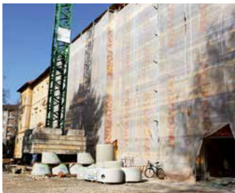
Na snímke budova gymnázia v rekonštrukcii . Gymnázium sa zlúči s tunajšou ŠUP-kou do jednej spojenej školy.
