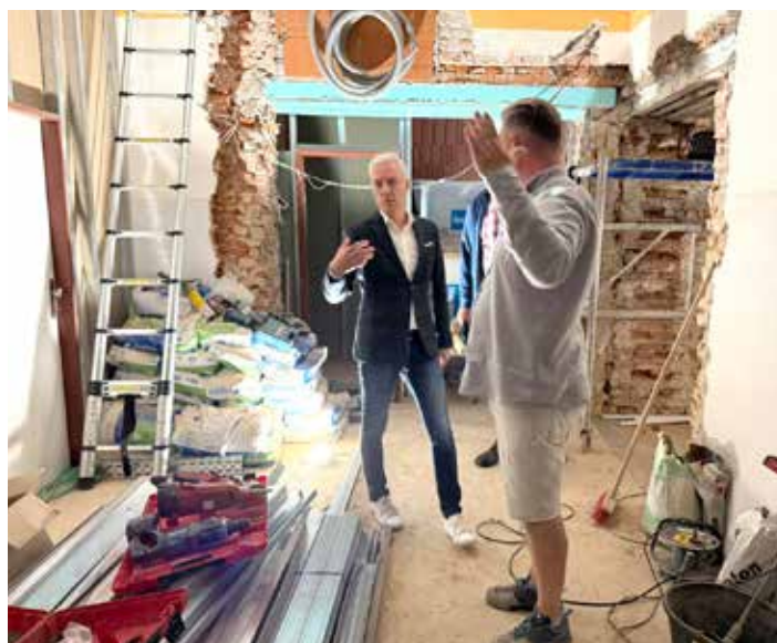
Rekonštrukcia priestorov v Nemocnici Dr. Vojtecha Alexandra v Kežmarku.
