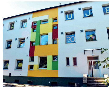
Zateplenie budovy Materská škola Cintorínska.
