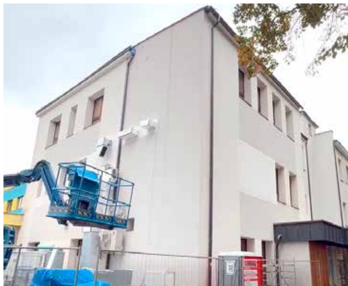
Rekonštrukcia Chirurgie nemocnice Dr. Vojtecha Alexandra Potrebné dofinancovanie projektu: 80 000 Eur
