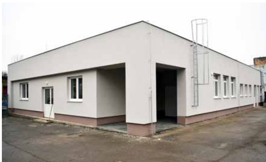
Zrekonštruovaná budova na Poľnej ulici.
