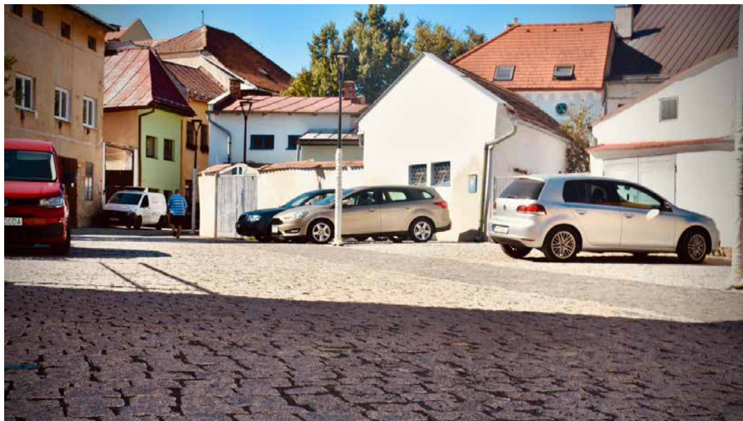
1. Prvá etapa rekonštrukcie Kostolného námestia je sfinalizovaná.
