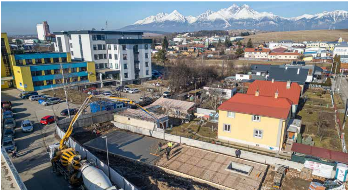
Práce na projekte Nízkokapacitného zariadenia pre seniorov napredujú.
