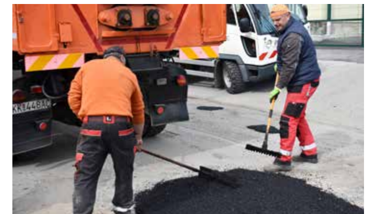
Výspravka chodníkov horúcim asfaltom.
