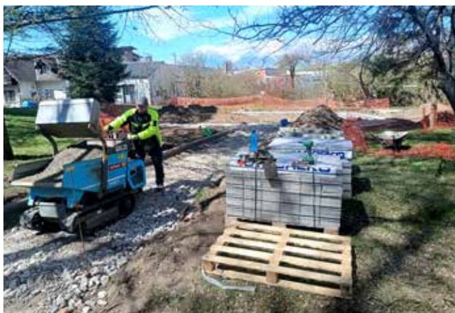
Prvé práce na stavenisku sa už rozbehli.
