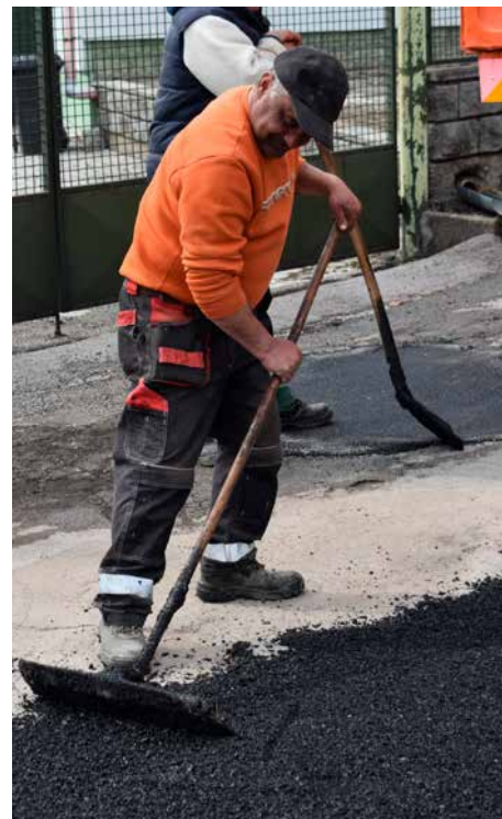
Pracovníci VPS pri oprave výtlku asfaltobetónom.
