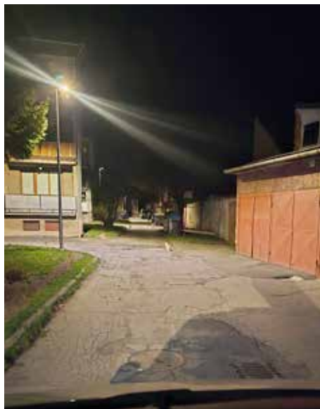
Verejné osvetlenie bolo vymenené aj pri bytových domoch.
