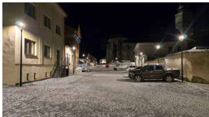
Rekonštrukcia verejného osvetlenia bola súčasťou rekonštrukcie Kostolného námestia.
