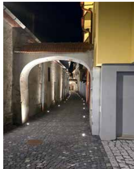
Historické uličky s podpernými oblúkmi efektívne osvetlili nové bodové LEDky umiestnené v dlažbe.
