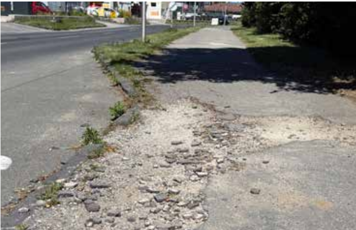
Takto rozdrobený povrch chodníkov potrebuje komplexnú renováciu.
